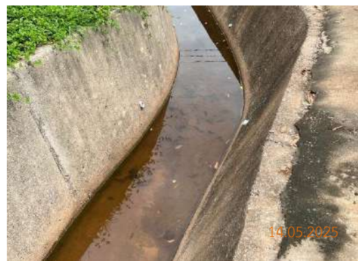
รูปที่ 2-5 รางระบายน้ำฝนของโครงการ
