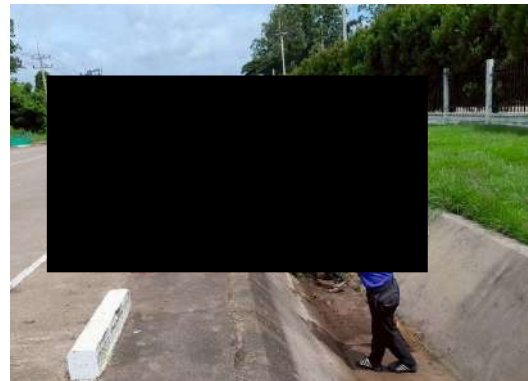
รูปที่ 2-11 การขุดลอกตะกอนในรางระบายน้ำฝน
